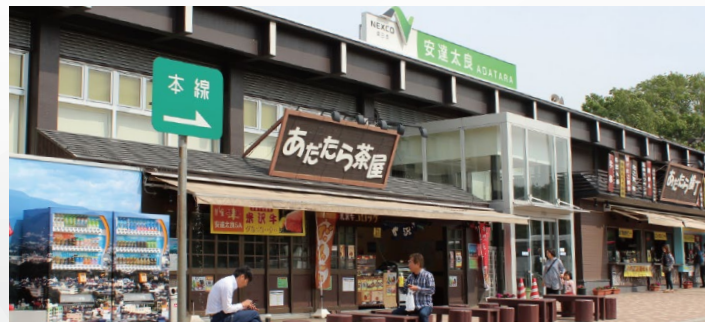
安達太良サービスエリア(東北自動車道上り) 福島県本宮市本宮字天ヶ 221 | 電話: 0243-33-1151
